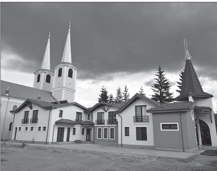
A felújított templom és a bölcsőde adminisztrációs épülete. Szabó Ákos felvétele
