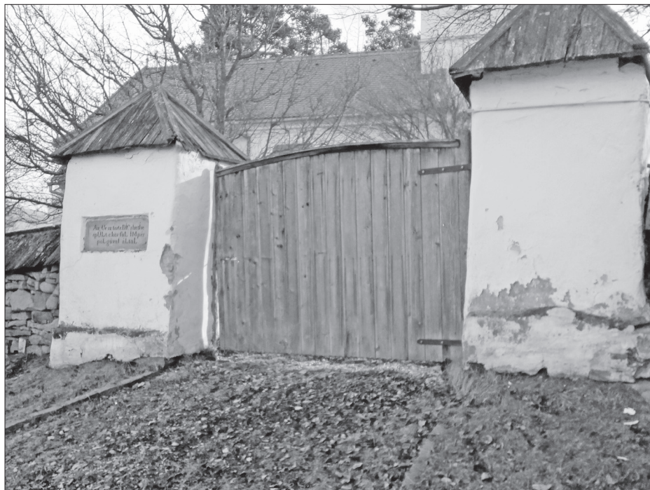
A kászonszéki római katolikus kápolna kapubejárata
