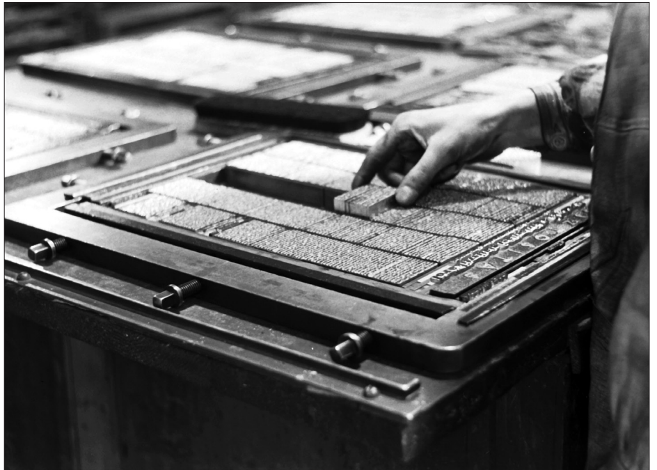
1938, újságoldal tördelése Linotype szedőgéppel kiöntött sorokból. Ezt az eljárást az 1990-es évekig alkalmazták. Forrás: Fortepan/Chuckyeager Tumblr
