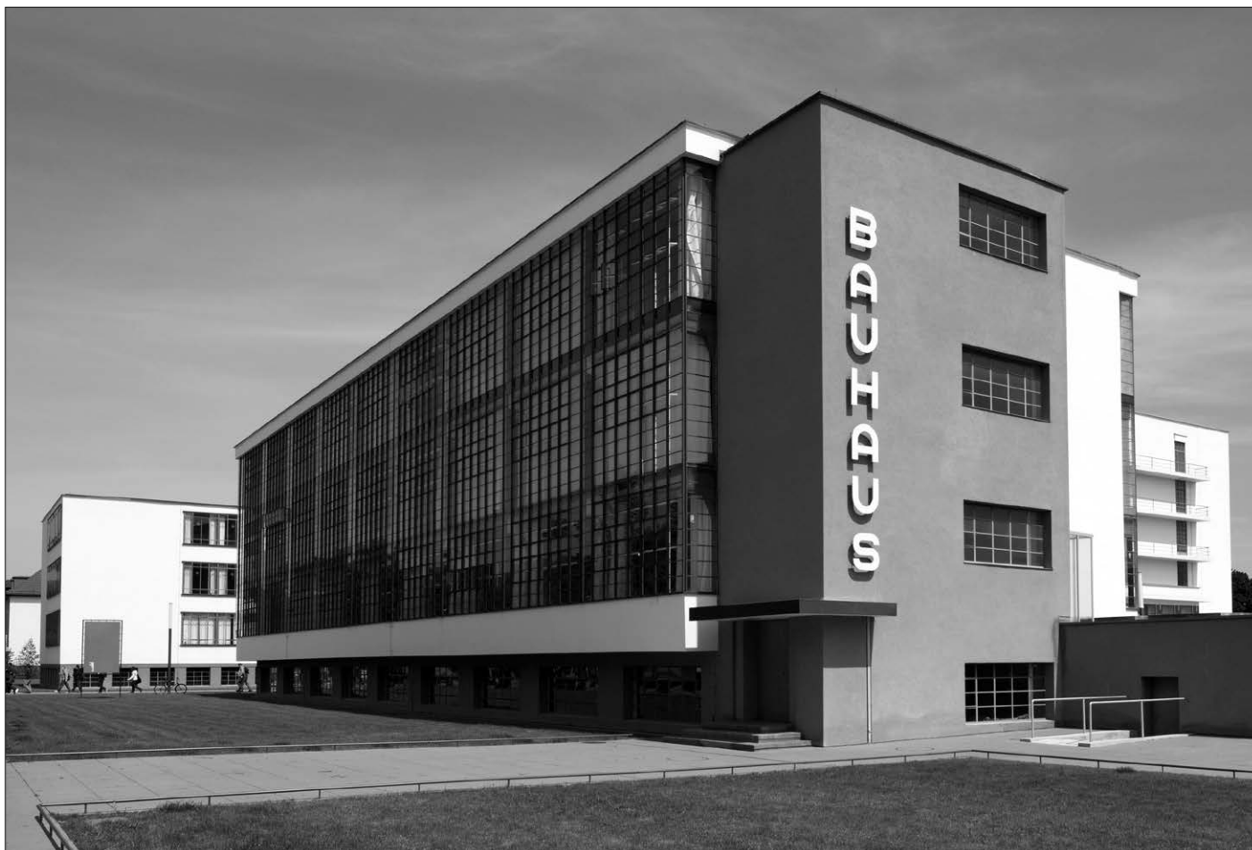
A dessai Bauhaus épülete
