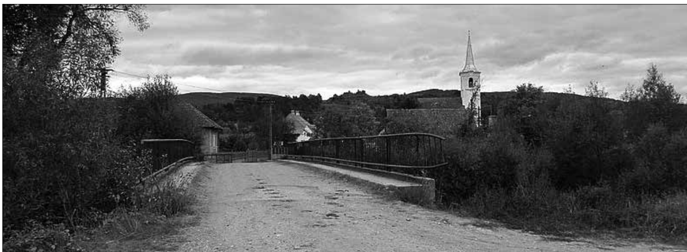
A nagykadácsi új vasbetonhíd
