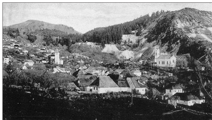
Verespatak a 19–20. század fordulóján – ekkor 190 bányabirtok területén folyt termelés (forrás: http://www.abrudbanya.ro/administration/media/Verespatak/verespatak%20latkep.jpg )
