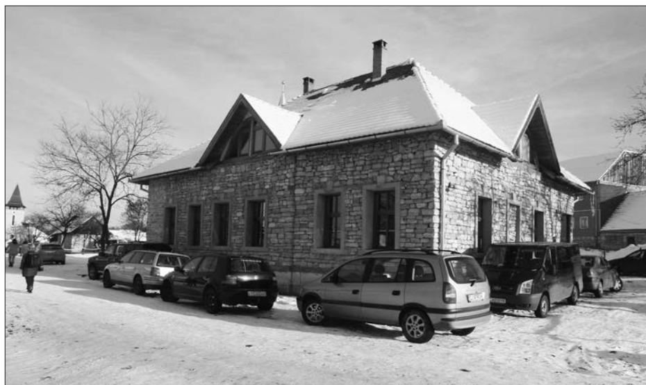
Csak a járművek másak. Az iskolaépületet eredeti alakjában építették újra
